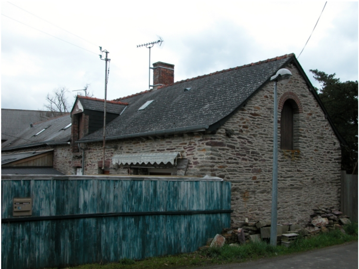
Vue de 3/4 du logis sud
