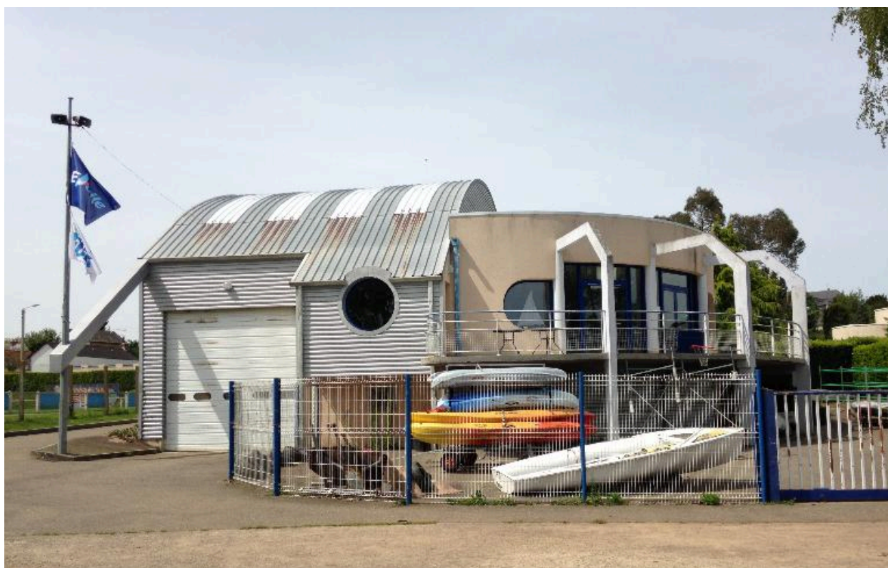
Vue générale prise du sud
