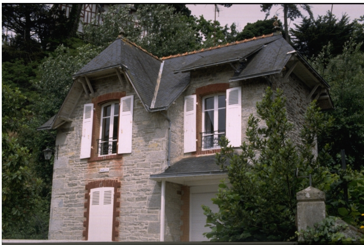
Villa, dite Mamilou, 8 rue des Chalets-Steck
