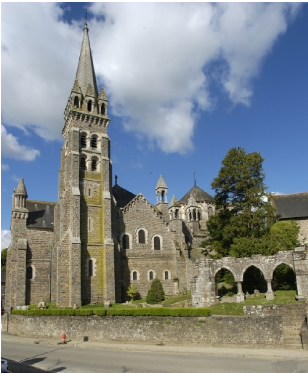
Elévation nord-est et vestiges de l'ancienne église
